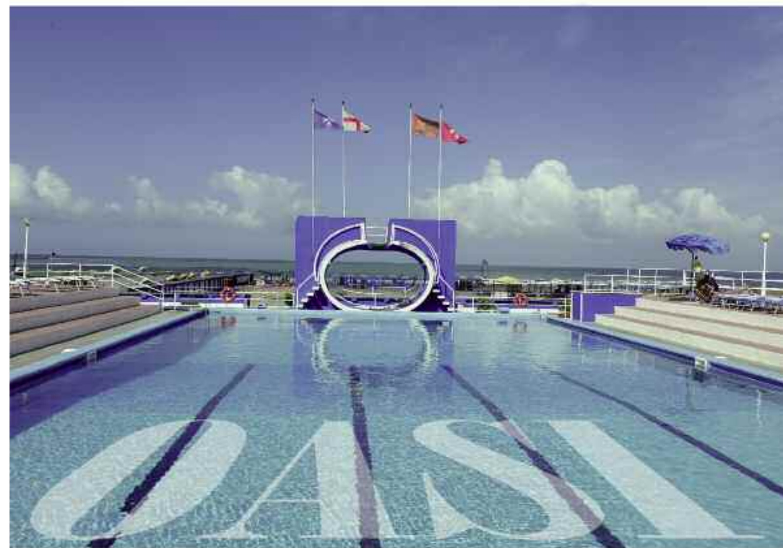
Piscina olimpionica sopraelevata con trampolino da 5 metri
