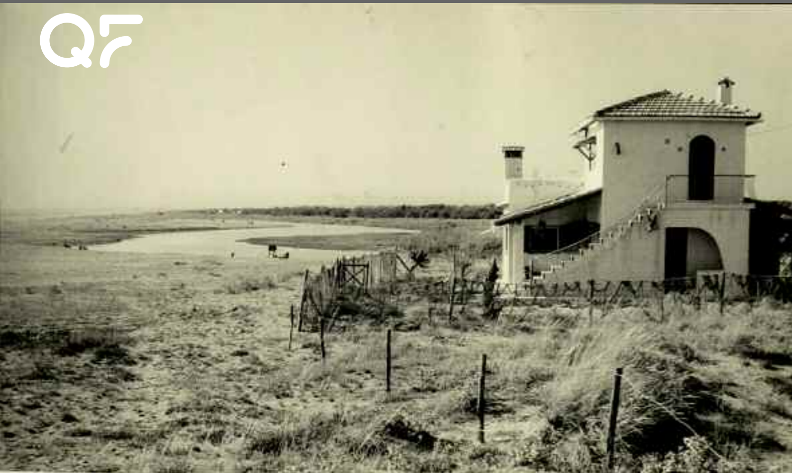
- Costruzioni esistenti sull'arenile demaniale tra Fregene e l'Arrone.
