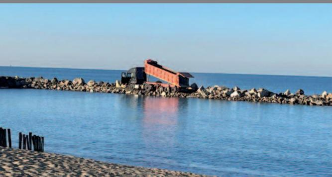
Iniziati a metà febbraio, con la cantierizzazione delle aree, proseguono i lavori di manutenzione e rifioritura delle scogliere ammalorate del lungomare di Focene con conseguente ripascimento.
